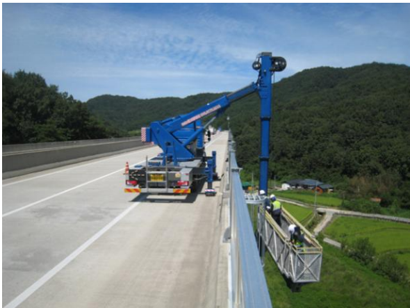
굴절점검차를 이용한 근접조사
