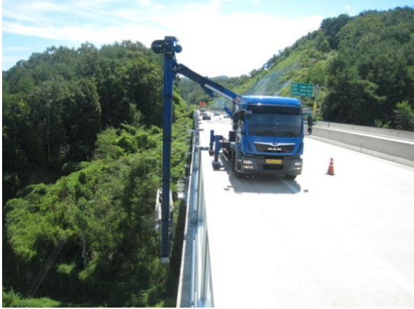
굴절점검차를 이용한 근접조사
