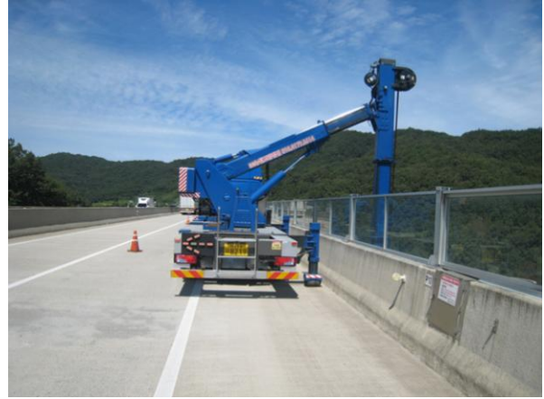
굴절점검차를 이용한 근접조사
